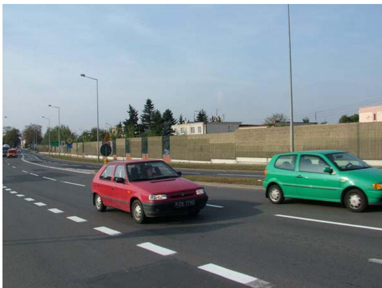
Fot. 5.1. Ekran akustyczny – węzeł Dębina
